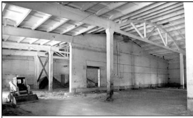
Ведется реконструкция новых производственных цехов.
